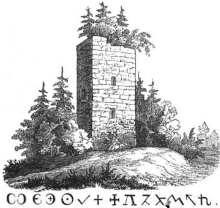
Der Rötherthurm bei Mittel-Roth. Oberamts Gaildorf.
