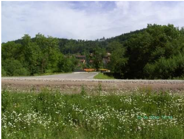
10. Juni 2010 Blick zur Zufahrtsbrücke für die Fa. Scholz Recycling AG & Co.KG
