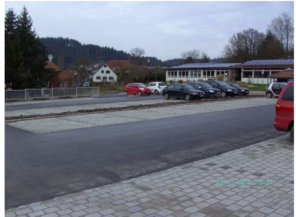
Die Parkplätze sind fertig gestellt.
