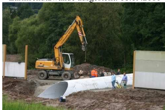
Die Fußgängertunnelröhre wurde eingelegt. 08.09.2010
