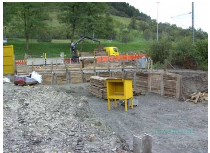
Der Aushub geht voran, damit die Wände nicht einstürzen, werden diese mit Holzstämmen gesichert. Aufnahmen vom 16.09.2010.
