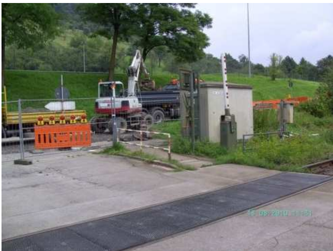
Die Maßnahmen wurde begonnen - Aufnahme vom 13.08.2010
