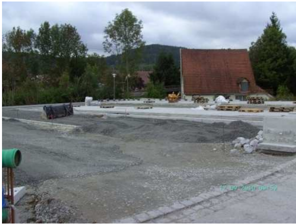
Die Arbeiten an den Parkplätzen sind in vollem Gange. 17.09.2010
